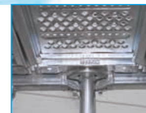
Vlonders met U-oplegging kunnen over de rozet heen worden gelegd.
