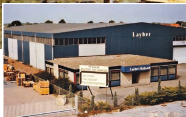
Le premier emplacement à Lissenveld 13 à Raamsdonksveer
